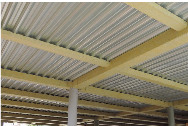
Obr. 1 – Příklad použití výrobku ISOVER FireProtect® 150 (ISOVER Tank Roof Slab 20 kPa)
